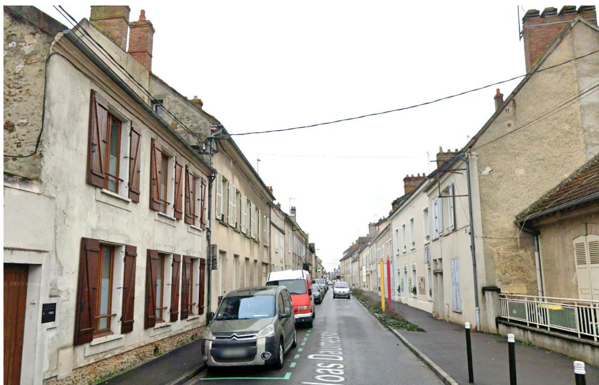
Exemple d'homogénéité visuelle créée grâce à l'alignement de l'ensemble des constructions, ici rue Noas Daumesnil.
