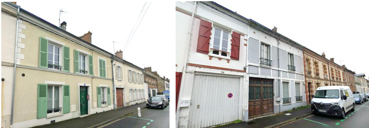
Exemples de maisons de bourg situées le long des rues Noas Daumesnil et Général Leclerc.
