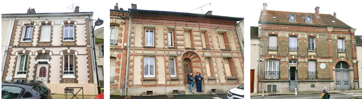
Exemples de façades richement décorées, notamment grâce à l'usage de la brique pour créer des éléments de décors.
