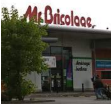
Enseigne en toiture
